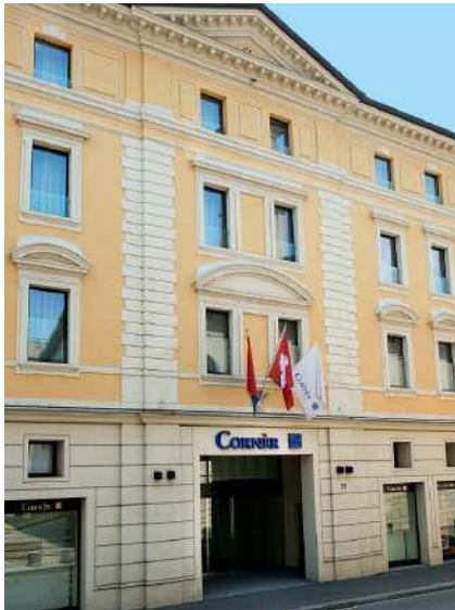
Il quartier generale in via Canova
